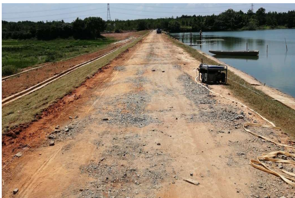
水库正在实施除险加固
